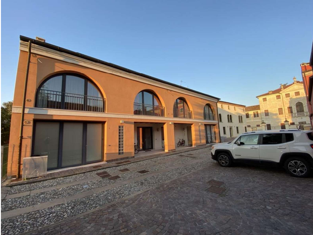
Prospetto sud con accesso unità immobiliare (piano terra a sx)
